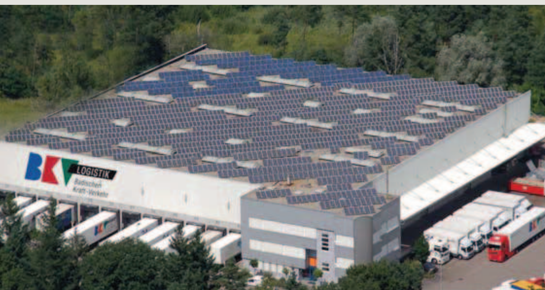
Vorreiter bei der Photovoltaik: Die Anlage arbeitet seit 2004.
